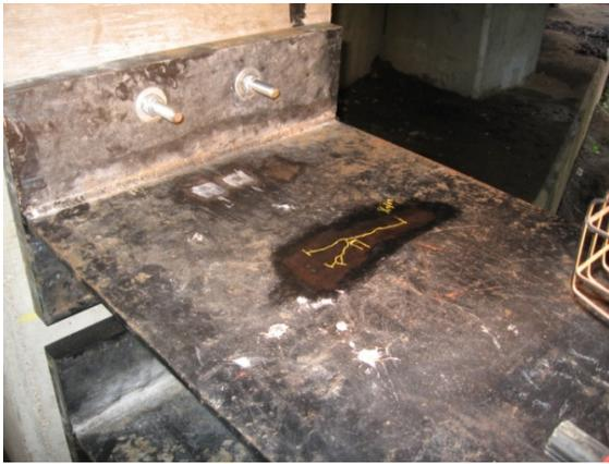
a. Top web plate cracking
